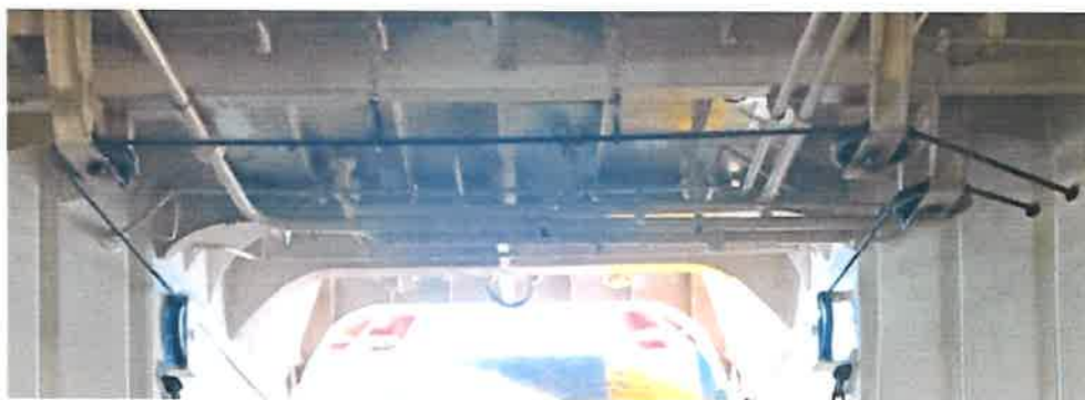
Slika 8. Sustav čelične užadi i koloturnika za podizanje/spuštanje pramčane rampe
